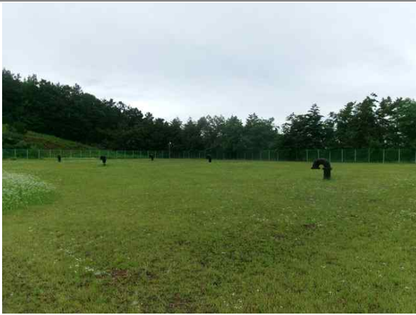
배수지 상부 현황
