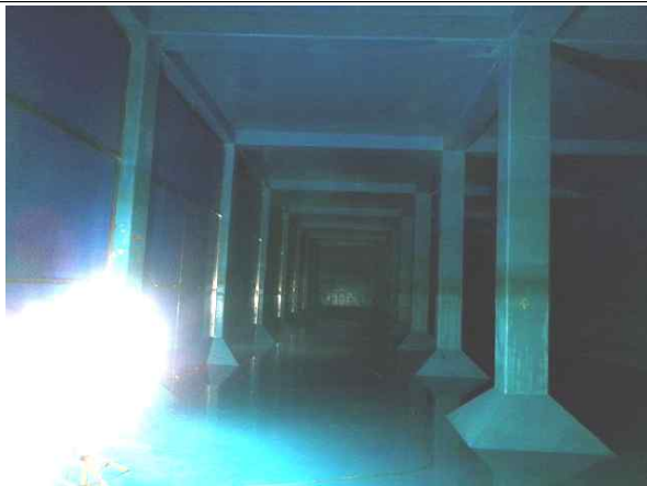
배수지 1지 내부 전경
