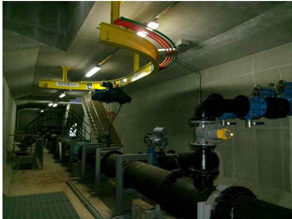
유입밸브실(지하1층) 내부 전경
