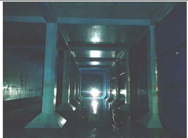
배수지 2지 내부 전경
