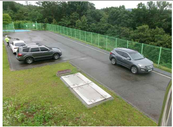
아스콘 포장 현황
